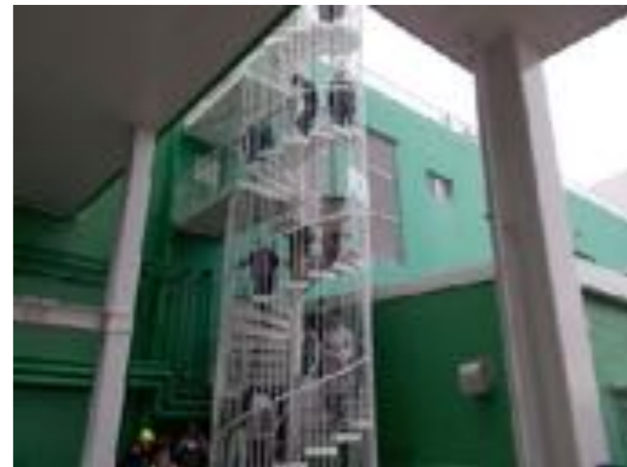
避難する屋上を確認
